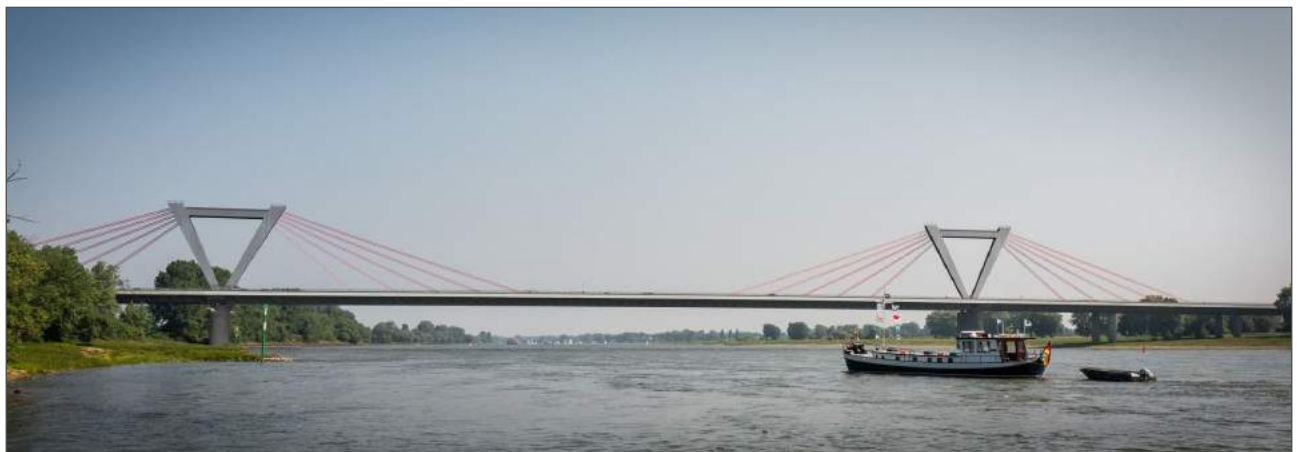
Abb.: Flughafenbrücke Meerbusch/Düsseldorf Quelle: https://www.flickr.com/photos/hhatoto/42182839872
